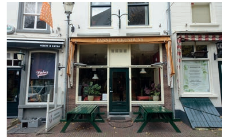
Terrasdeel direct aan de gevel
