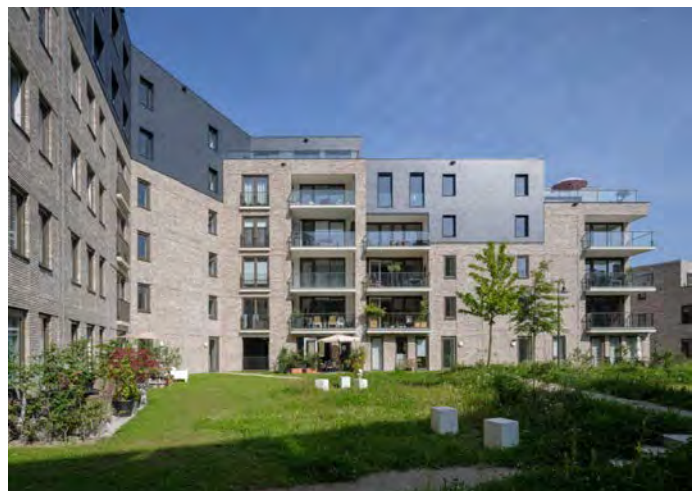
Grondontsloten en grondgebonden woningen met tuin op verhoogd maaiveld. Balkons als buitenruimte voor de appartementen. Kade Noord, Zutphen
