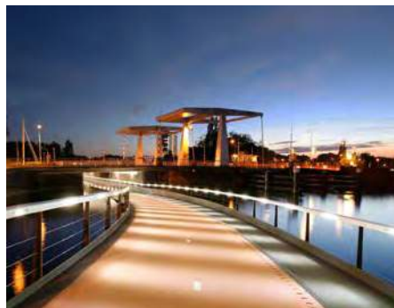
Fietsunderpass, Delft. Referentie voor fietspad onder de Koppelbrug
