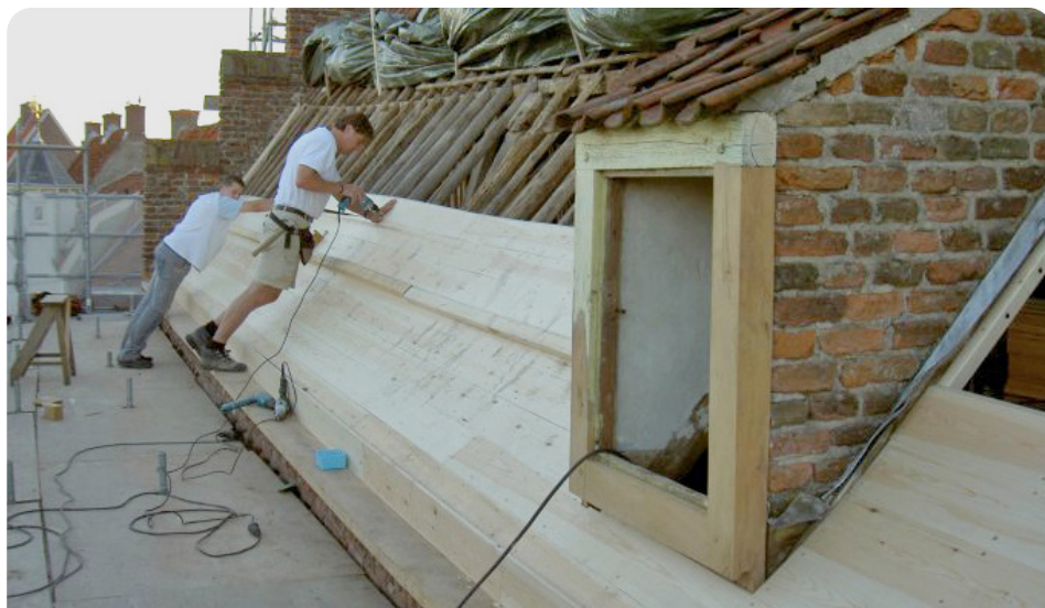
Bij de renovatie van dit monumentale dak wordt houten dakbeschot en isolatiemateriaal toegevoegd. Het houten kozijn van de dakkapel is plaatselijk hersteld, met behoud van zoveel mogelijk oorspronkelijk materiaal.
