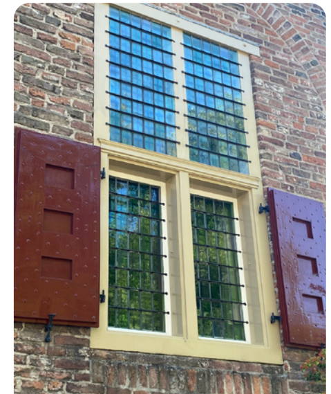
Bij dit type glas-in-loodramen kan alleen een geïsoleerd voorzetraam aan de binnenzijde worden geplaatst.
