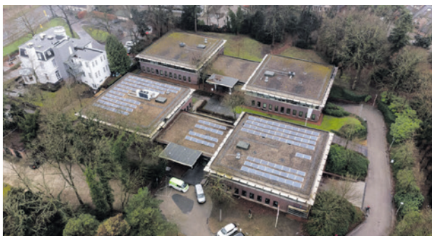
Het hoofdkantoor van GGD Regio Utrecht staat in Zeist (bron: KlimaatService Holland).
