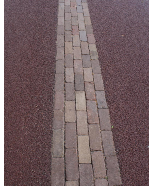
Fietsstraat: rood asfalt met middenstrook van betonklinkers
