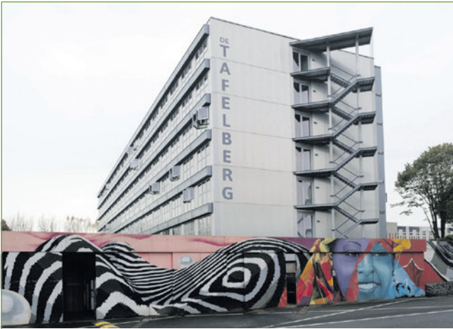
In De Tafelberg in Amsterdam hebben jongeren een eigen woning, maar zijn er ook gezamenlijke ruimtes om elkaar te ontmoeten (foto: tafelberg.nl).
