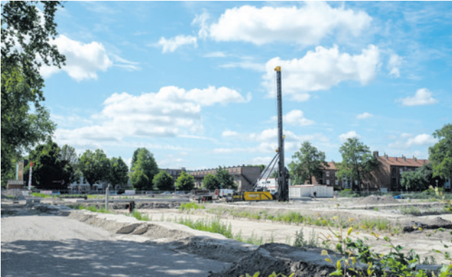
Woningbouw in Randenbroek. Amersfoort gaat tot 2040 elk jaar ongeveer duizend nieuwe woningen bouwen. Dat staat in het nieuwe Omgevingsprogramma Volkshuisvesting (foto: Simon Lamme).
