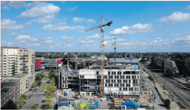
Op de Trapeziumlocatie wordt nu het Huis van de Stad (het nieuwe stadhuis) gebouwd. Daarachter begint naar verwachting in 2028 de bouw van 230 tot 280 appartementen (foto: Tristan Melissen).
