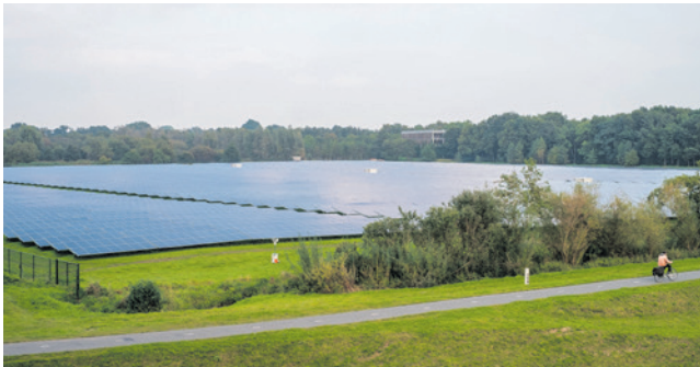
De regio gaat zoeken naar nieuwe plekken voor zonne- en windenergie om het gezamenlijk opwekdoel voor 2030 te halen (foto: Simon Lamme).
