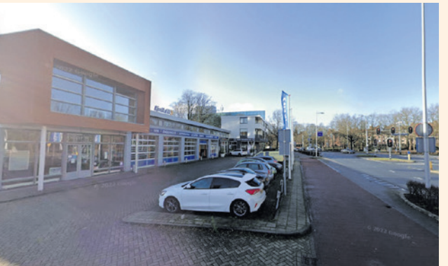
Aan de Hogeweg 45 komt, op de plek waar nu nog een KwikFit en het oude pand van woninginrichter Van Wiefferen staan, een appartementencomplex met ongeveer zeventig woningen (beeld: Google Maps).
