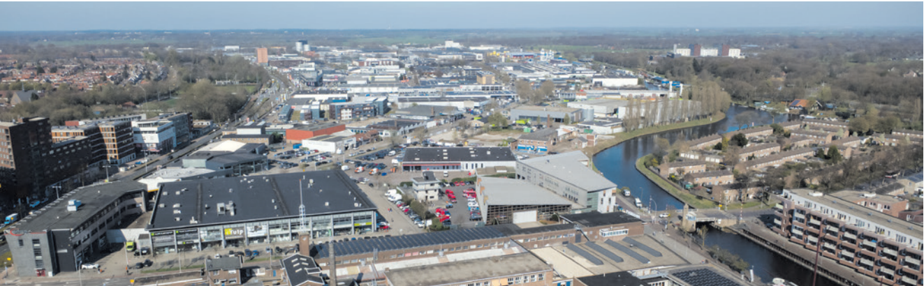
De raad werkt toe naar besluitvorming over twee windturbines op bedrijventerrein Isselt. De fractie van Amersfoort voor Vrijheid wil weten hoe onderzoek naar geluid bij windturbines werkt (foto: Tristan Melissen).
