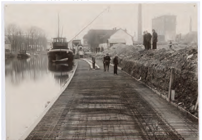
Afbeelding 16. Werkzaamheden aan de kademuur van de Kleine Koppel ter hoogte van Rohm en Haas en de Prodentfabriek in 1936 (bron: Archief Eemland)
