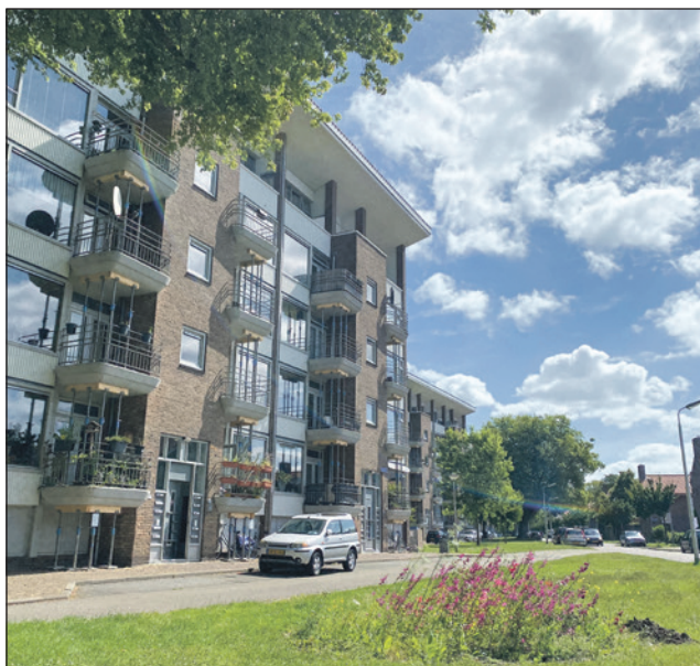
Flats in de straat Vreeland (foto: griffie).
