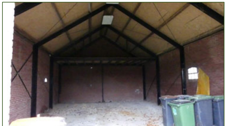
Binnenzijde opstal A (bron: FF Solutions)
