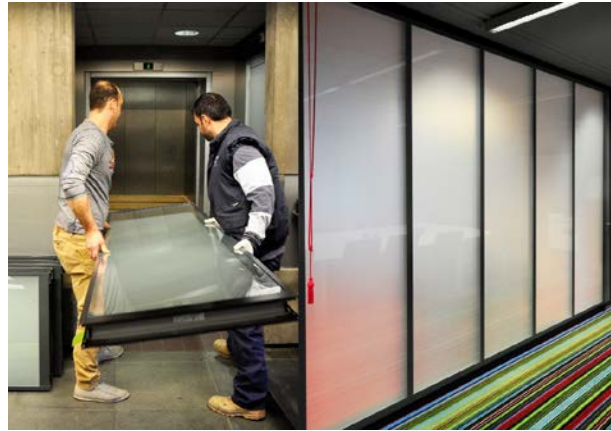
Bij de aanpassing van een kantoor in Utrecht zijn diverse glazen binnenwandelementen hergebruikt in een nieuw kantoor.
