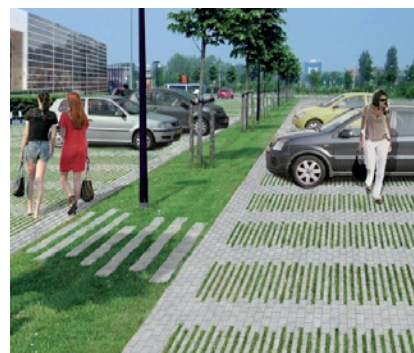
Parkeerplaatsen met open verharding
