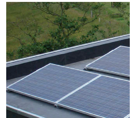
Zonnepanelen op platte daken
