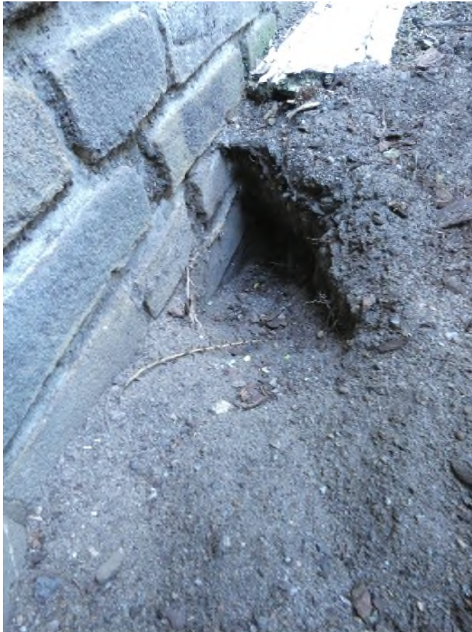
Figuur 2.5. Geschikte inkruipopening voor boom – en steenmarter in gebouw de Hebron.
