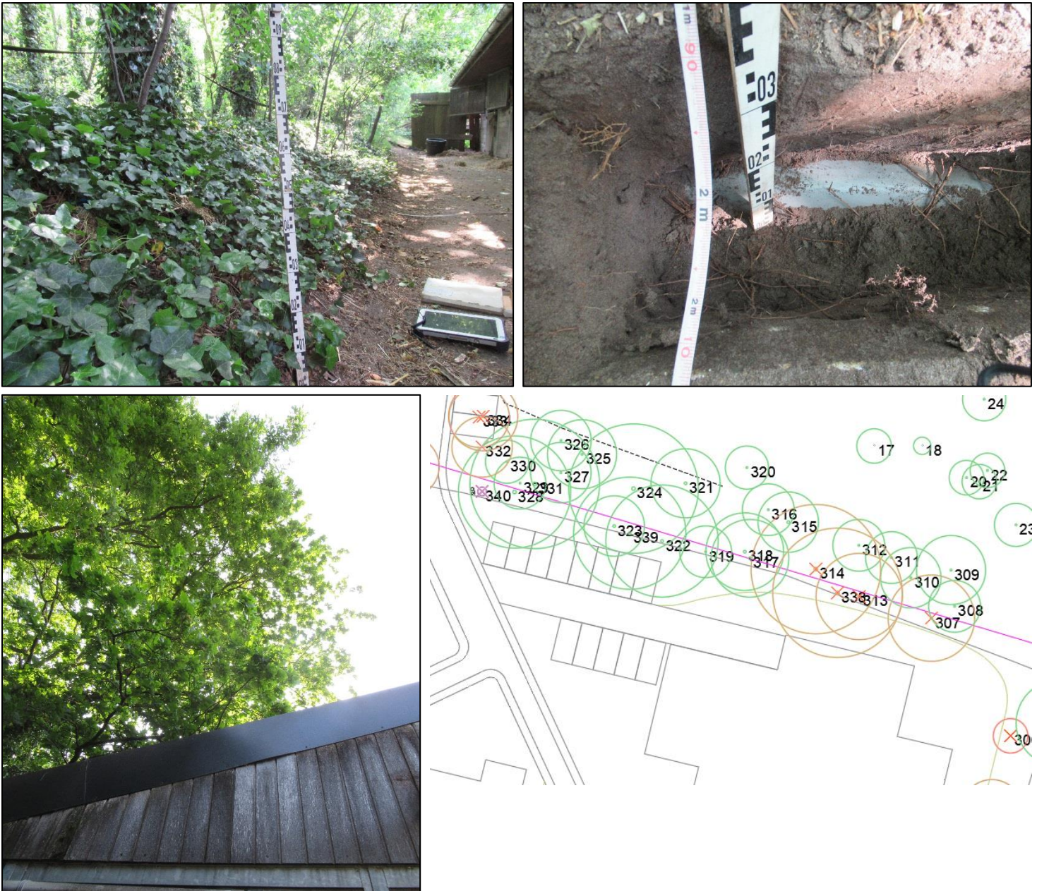
Foto linksboven: bomenrij op talud circa 0,7 m boven omliggende maaiveld van de paardenstal.
