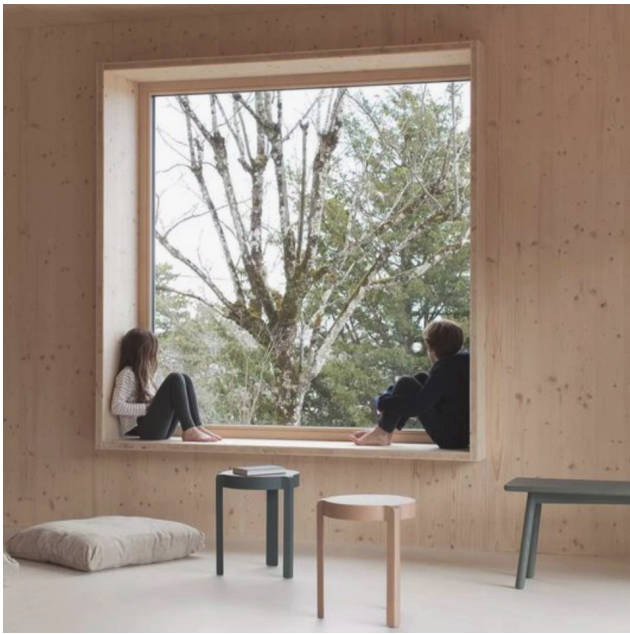
Raamkozijnen (binnen) De binnenkozijnen zijn gemaakt met kruisgelamineerde houten panelen van geschuurd multiplex, A-kwaliteit (21/24/27mm), in natuurlijke houtkleur (lichtroze) en met een matte afwerking, rondom het raam.
