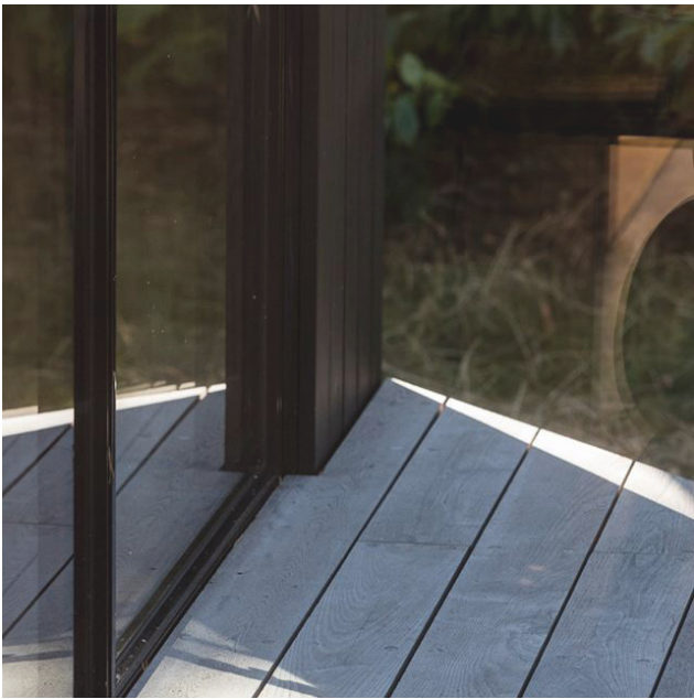
Terrasplanken Gecomprimeerde en thermisch behandelde bamboe terrasplanken. Oppervlakteafwerking met groeven in verweerde grijze kleur.
