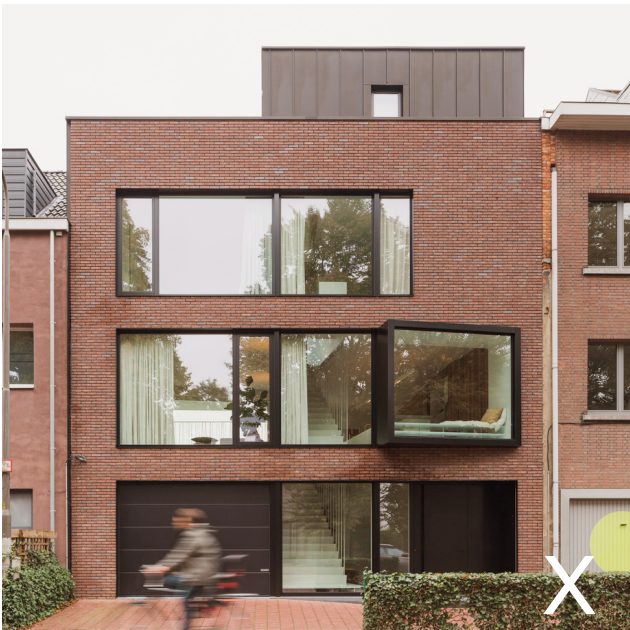
Nieuwe structuren zichtbaar vanaf de straat
