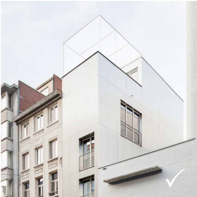
Kas met plat dak
