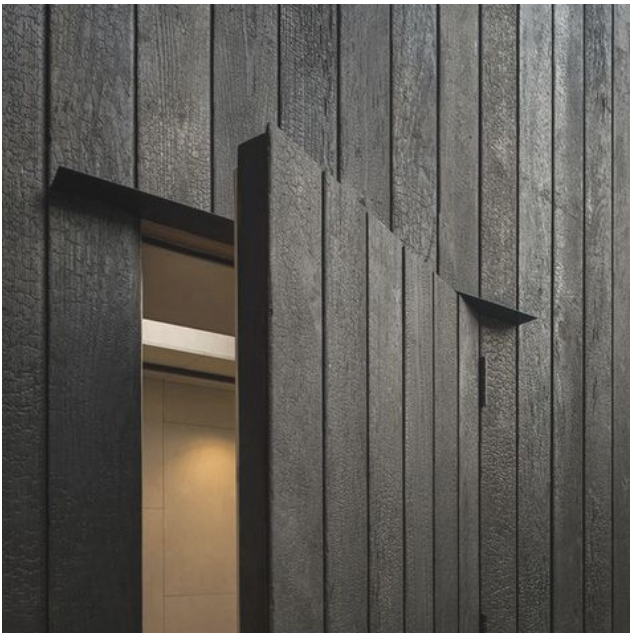
Verborgende deur In situaties waar de gevelsamenstelling een meer solide uitstraling vereist, worden verborgen deuren toegevoegd in hetzelfde materiaal en dezelfde kleur van de gevel.
