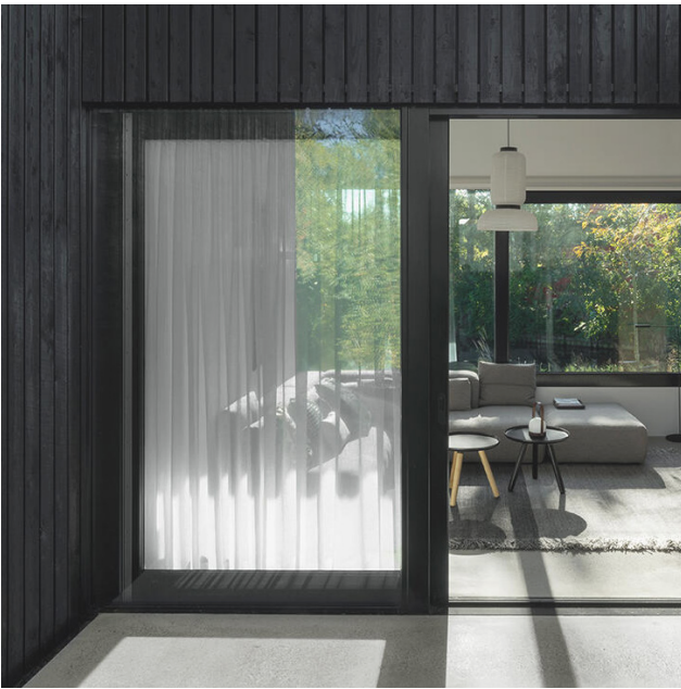
Raamkozijnen (buiten) De buitenste kozijnen zijn gemaakt van aluminium, gepoedercoat en geanodiseerd (passend bij de kleurstelling van elke woning). De kaders zijn verborgen.
