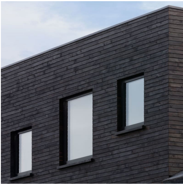
Horizontaal hout Voor de gebouwen met een plint zijn de bovenste niveaus van de gevel uitgevoerd met horizontale houten planken.
