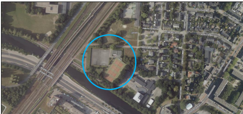
afbeelding 1: luchtfoto huidige situatie
