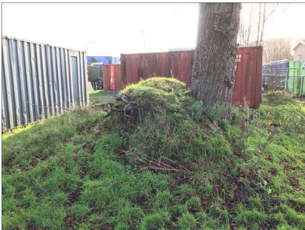
Afbeelding 9: In het verleden is aan één zijde van de boom grond afgegraven;
