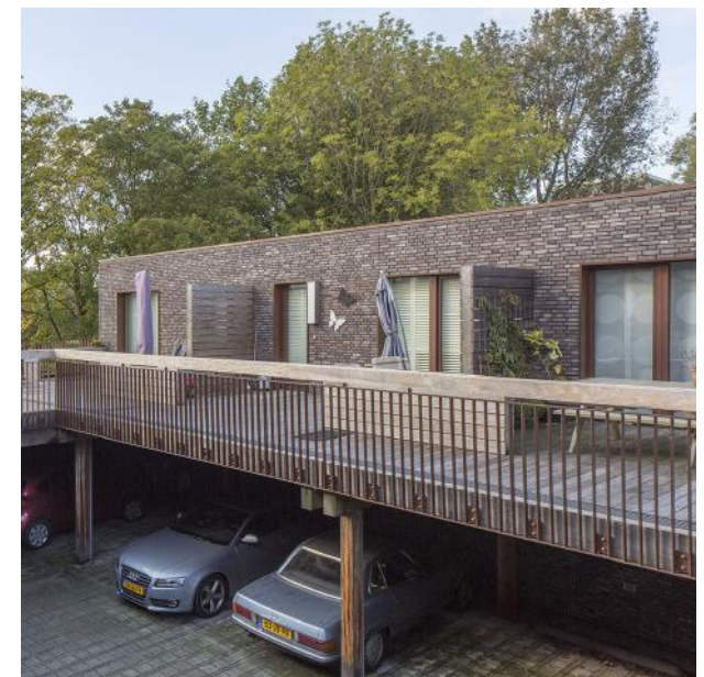
Referentie terrassen op dek boven parkeren
