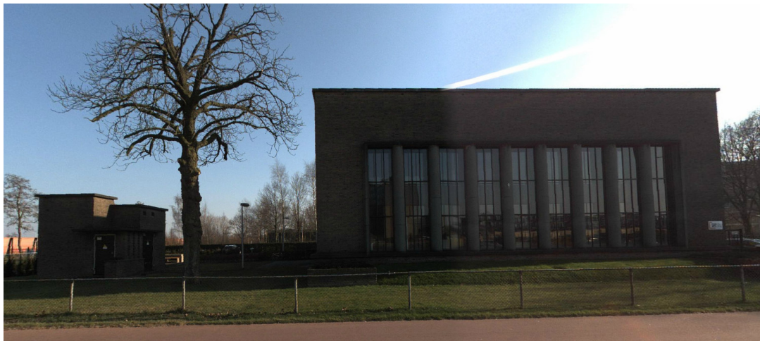
Links het transformatorhuisje, rechts het pompstation
