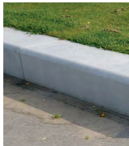
sfeerbeeld betonnen gazon/ trottoirbanden ter voorkoming van parkeren in het gras
