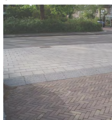
sfeerbeeld in/uitritconstructie naar de woon- straten, nader uit te werken volgens RIOR gemeente Amersfoort
