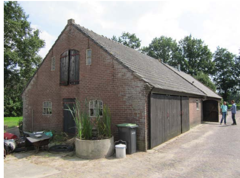
Achterzijde; topgevels lopen voorlangs het dak.
