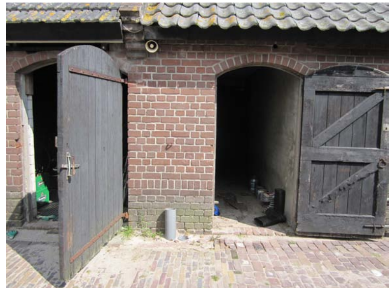
Zijgevel; enkele deuren zonder kozijnen.
