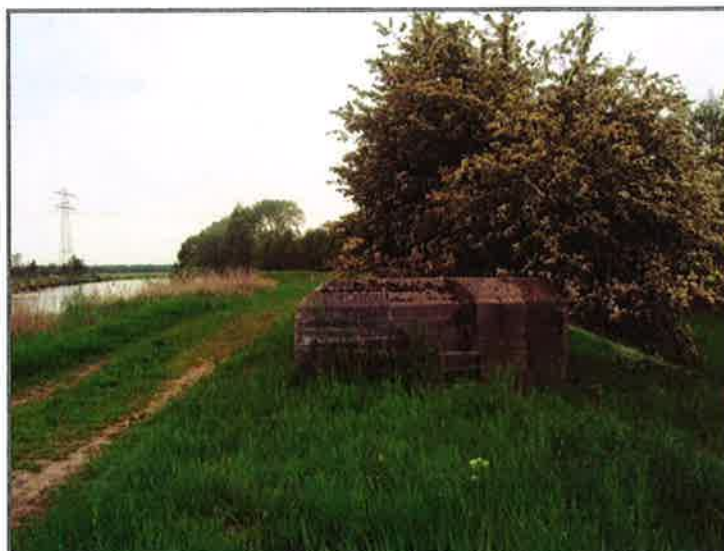
Bovenkant van de Grebbeliniedijk met een bunker en links de Eem
