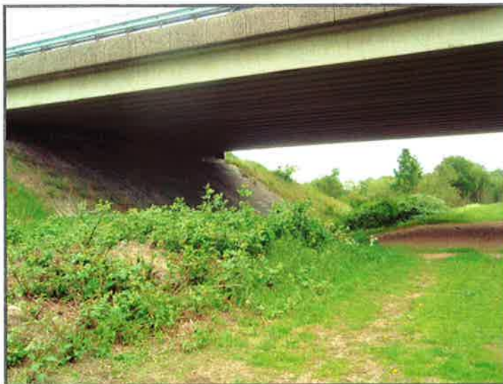
Brug van de N199 over de Eem
