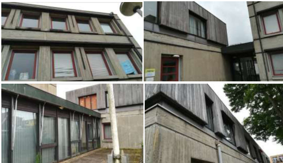
Figuur 3. Details van de bebouwing: linksboven kantoorgebouw, ongeschikt voor vleermuizen, rechtsboven laagbouw noordzijde, linksonder westzijde en rechtsonder zuidzijde: spleten langs onderrand van houten betimmering en langs zonweringen die mogelijk leiden tot verblijfplaatsen voor vleermuizen (foto's 14 juli 2020)
