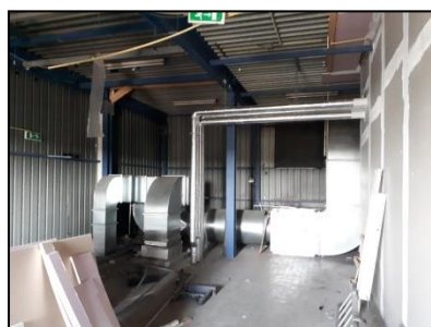
Figuur 6. Binnenkant dakopbouw.
