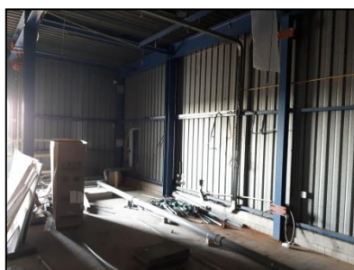
Figuur 7. Binnenkant dakopbouw.
