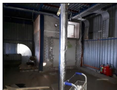
Figuur 8. Binnenkant dakopbouw.
