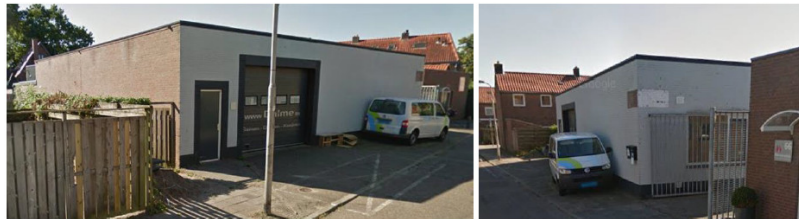
Aanzicht bestaande situatie
