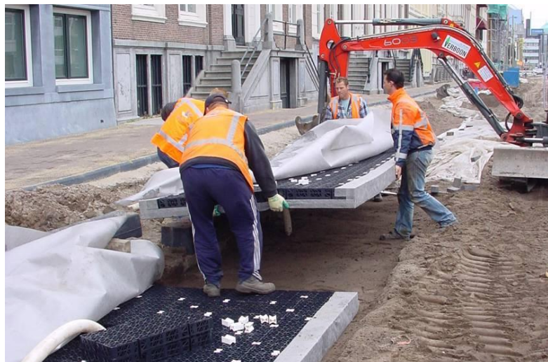
Plaatsen van Permavoid-platen onder parkeervakken in Den Haag.
