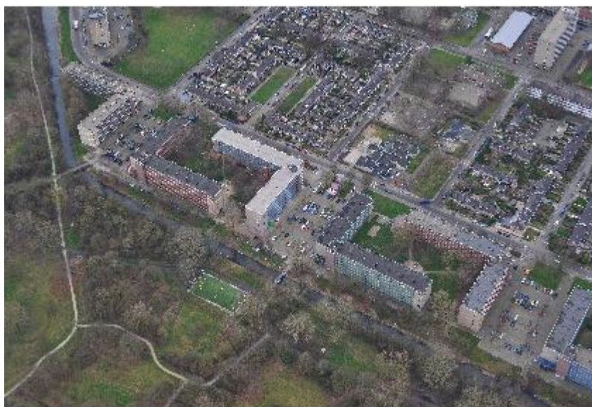
Huidige situatie vanaf noordzijde
