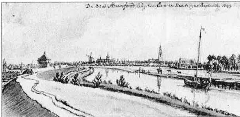
Liniedijk ter hoogte van de Glashut in 1749. De borstwering met walgang is hier nog niet aangebracht. Op dit traject zou dat pas gebeuren in 1799.
